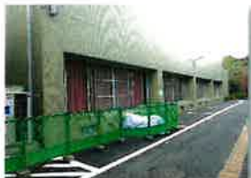
②建具、その他改修工事
